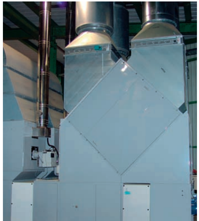
Kreuzstrom-Plattenwärmetauscher
